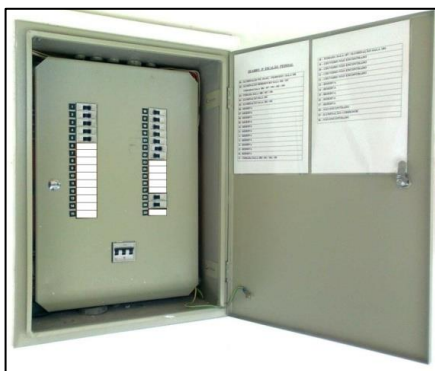
Figura 7 - Identificação dos disjuntores no quadro
