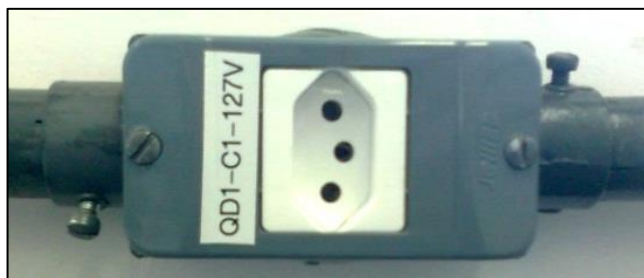
Figura 6 - Identificação tomada elétrica
